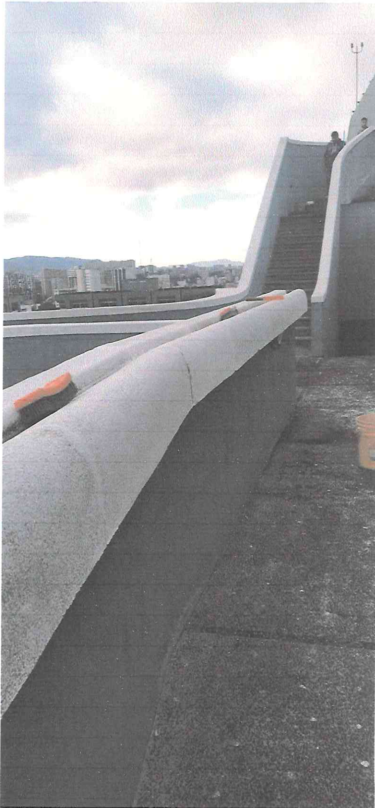
Limpieza de bordes blancos de las barandas en el sector 4 de la fachada oriente.
